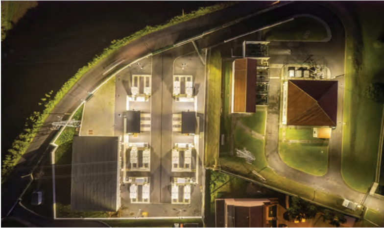
Figura 7- Sistema de Armazenamento de energia elétrica em baterias da ilha Terceira.
