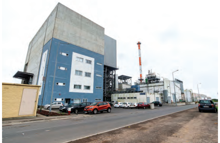
Figura 9 – Central de Valorização Energética de Resíduos
